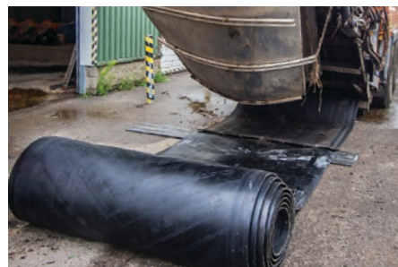
Napojenie nového pásu na pôvodný poškodený
